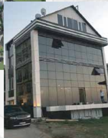
Vaat Yapı Head Office 1.000 m 2
